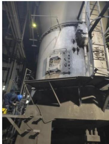
**Gambar 3.14** Pintu Akses Kecil Pada *Intermediate Housing*
