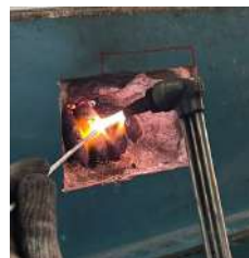
Gambar 4.6 Perbaikan Coil
