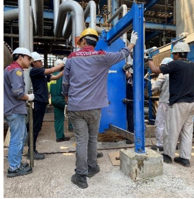
Gambar 4.11 Pemasangan Plate dan Pipa Heat Exchanger 321 (Sumber : Pribadi)
