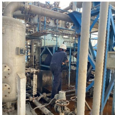
Gambar 4.8 Cleaning Jacket pada Kompresor (C-320) (Sumber : Pribadi)
