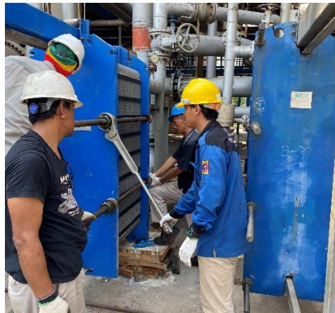
Gambar 4.12 Pemasangan dan Pengencangan Baut (Sumber : Pribadi)
