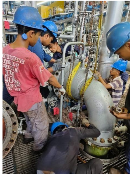
Gambar 5. 10 Pemasangan dan Perbaikan Valve MAE
