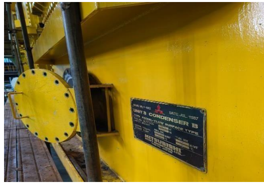
Gambar 3.7 Kondensor (Sumber : Dokumen Pribadi)
