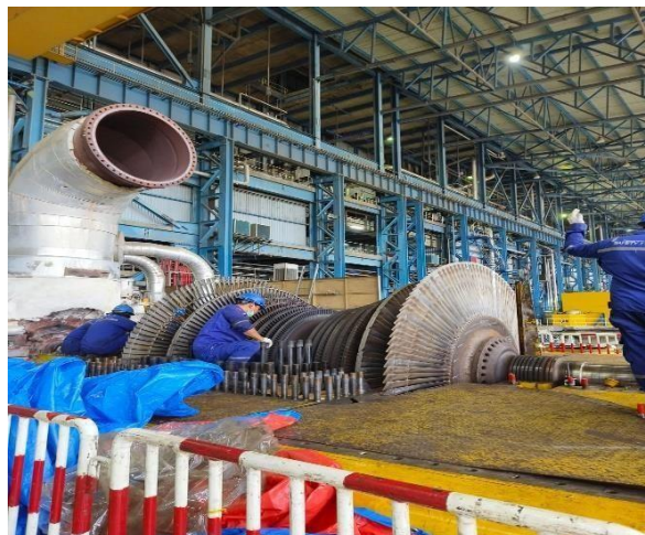
Gambar 5. 7 Pelepasan Rotor Turbin dari porosnya
