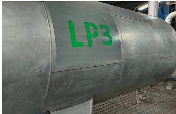
Gambar 3.9 Low Pressure Heater (Sumber : Dokumen Pribadi)
