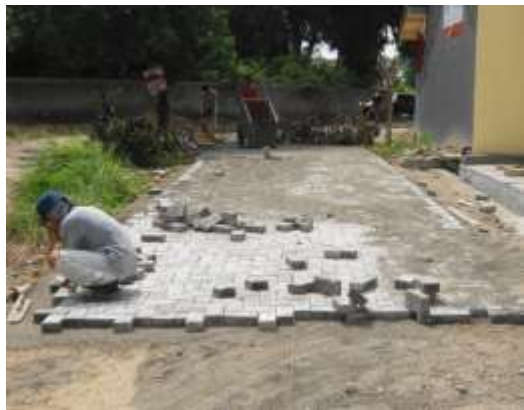
Kegiatan Padat Karya pembuatan paving blok kondisi 50%
