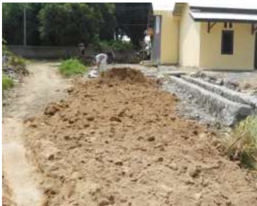
Kegiatan Padat Karya pembuatan paving blok kondisi 0%
