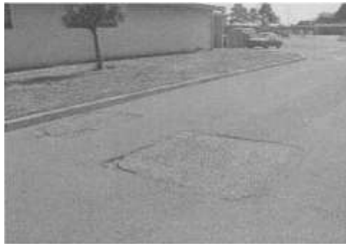
Gambar 3.14 Tambalan Dan Tambalan Pada Galian Utilitas
