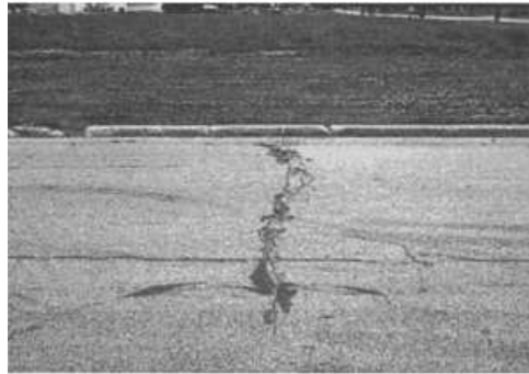
Gambar 3.13 retak memanjang dan melintang
