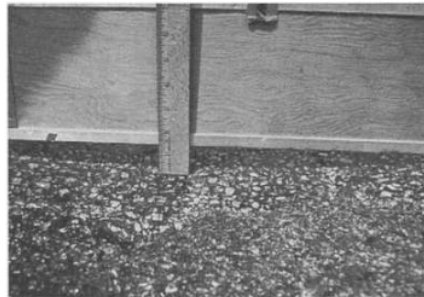
Gambar 3.18 kerusakan alur ( Rutting )
