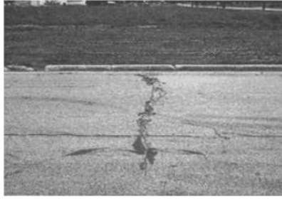
9 Gambar 3.13 retak memanjang dan melintang
