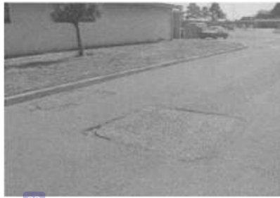
Gambar 3.14 23 Tambalan Dan Tambalan Pada Galian Utilitas
