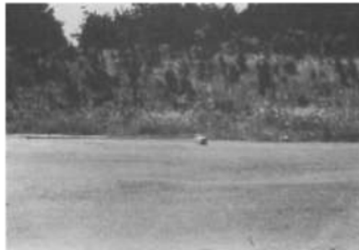
Gambar 3.21 kerusakan mengembang ( Swell )
