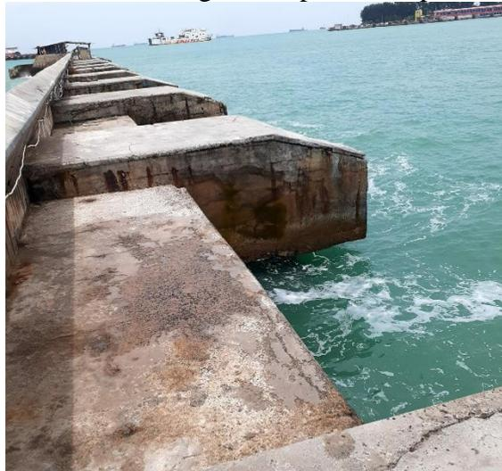
Gambar di atas adalah tempat pemecah ombak pelabuhan merak, dari celah-celah tersebut dapat dijadikan sebagai penempatan turbin atau rotor nantinya, kemudian sesuai dengan batasan masalah didapatkan dimensi dari penelitian (O. B. Yaakob et al., 2013) mendapatkan dimensi rotor seperti dipaparkan gambar di bawah ini.
