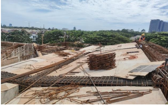
Pekerjaan Pasang Bekisting Pelat Lantai & Balok
