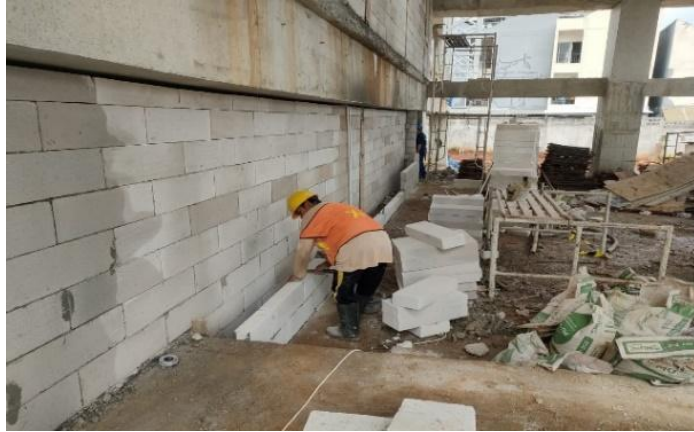
Gambar 3.23 Pemasangan Dinding Hebel Lantai 2 Gereja SPMBG
