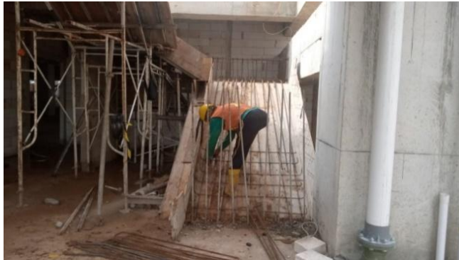
Gambar 3.19 Pekerjaan Penulangan Tangga 8 Lantai 2 ke 3 Gereja SPMBG
