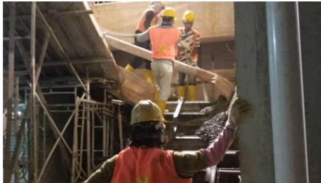
Gambar 3.20 Pekerjaan Pengecoran Tangga 8 Lantai 2 ke 3 Gereja SPMBG
