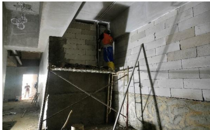
Gambar 3.24 Plesteran Dinding Lantai 2 Gereja SPMBG
