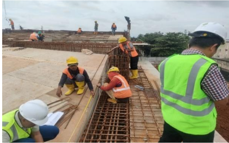
Gambar 3.11 Pekerjaan Penulangan Balok Lantai 4 Gereja SPMBG
