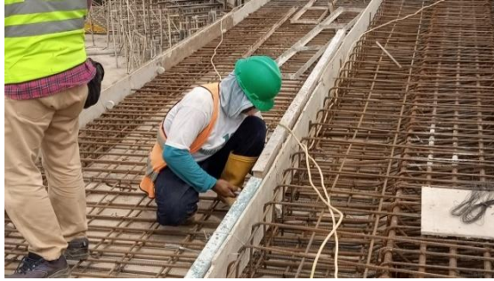
Proses Pemasangan Beton Decking
