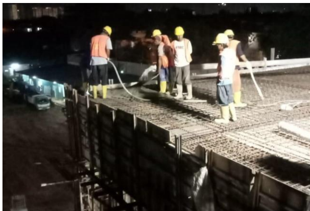
Gambar 3.16 Pekerjaan Pengecoran Pelat Lantai 4 Gereja SPMBG
