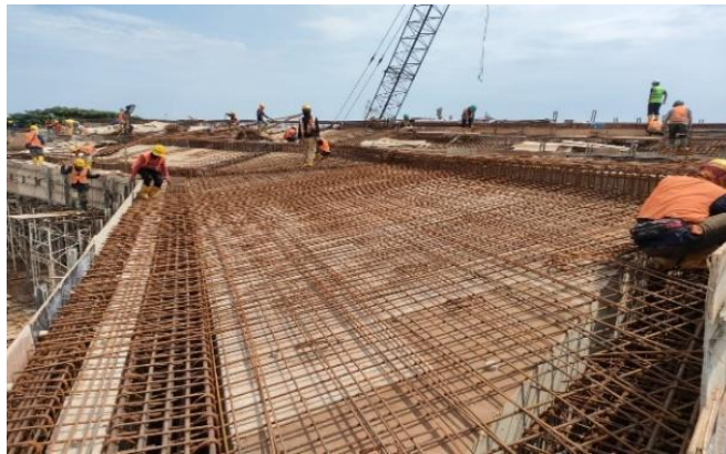
Gambar 3.15 Pekerjaan Penulangan Pelat Lantai 4 Gereja SPMBG
