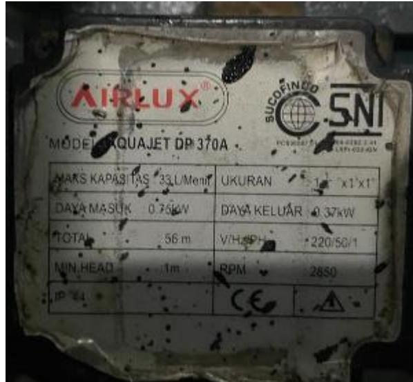
**Gambar 3.14** Nameplate dinamo yang digunakan
