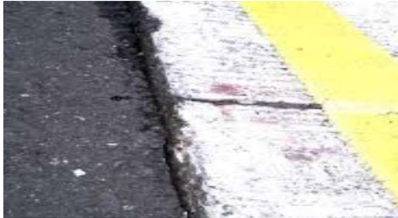
Gambar 3.2 Jenis Kerusakan Retak Sambungan Pelebaran Jalan (*Widening Crack*)
