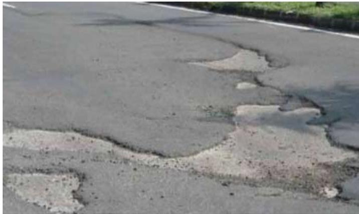
Gambar 3.16 Jenis Kerusakan Pengelupasan Lapisan Permukaan (*Stripping*)
