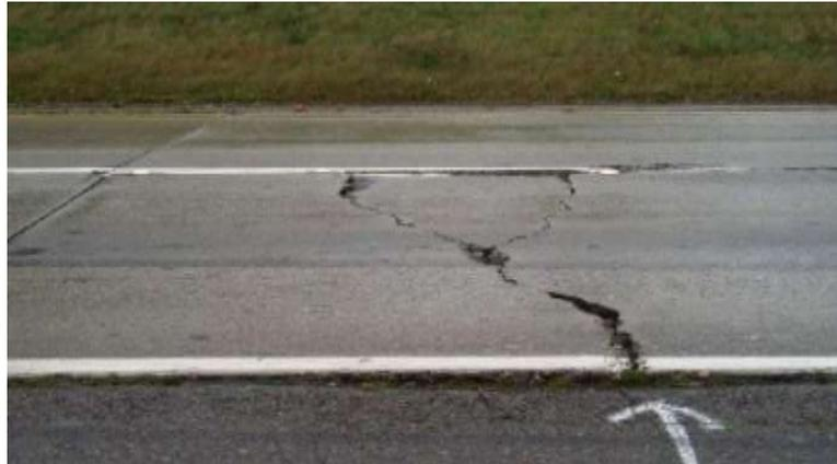
Gambar 3.5 Jenis Kerusakan Retak Sambungan Bahu dan Perkerasan (*Edge Joint Crack*)
