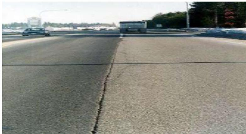
Gambar 3.6 Jenis Kerusakan Retak Sambungan Jalan (*Lane Joint Crack*)
