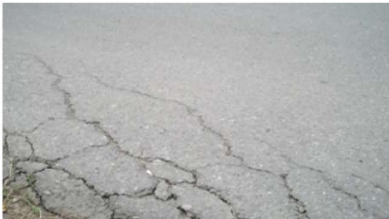
Gambar 3.4 Jenis Kerusakan Retak Pinggir (*Edge Crack*)
