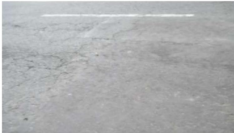
Gambar 3.2 Jenis Kerusakan Retak Halus (*Hair Cracking*)
