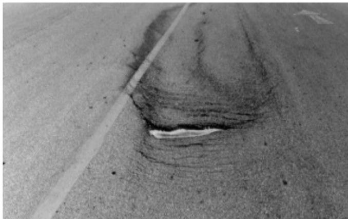
Gambar 3.8 Jenis Kerusakan Retak Selip (*Slippage Crack*)
