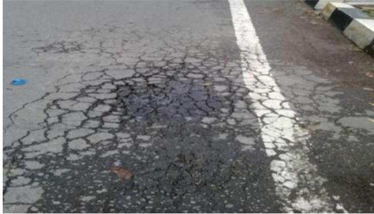
Gambar 3.3 Jenis Kerusakan Retak Kulit Buaya (*Alligator Crack*)
