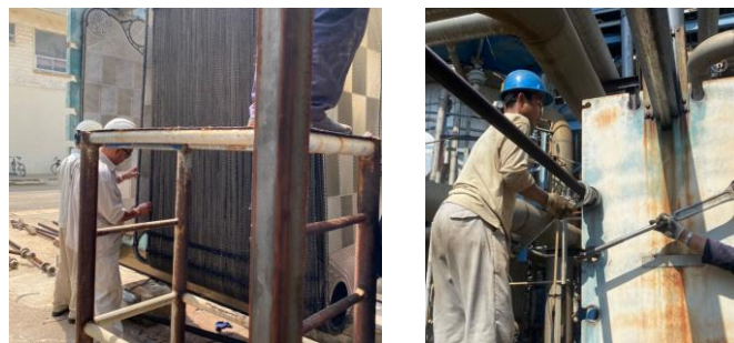
Gambar 4.13 Pengecekan & pemasangan frame
