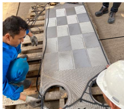
Gambar 4.12 Pemasangan Gaskets
