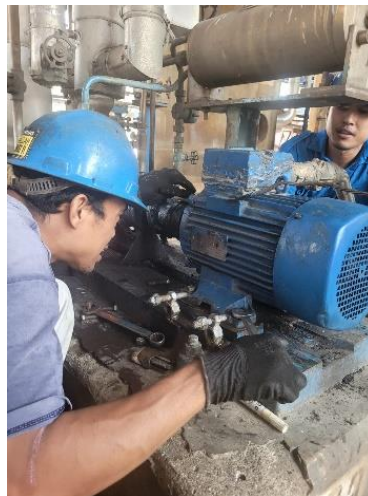
Gambar 5.8 Pemeriksaan Akhir sambil Memasang baut
