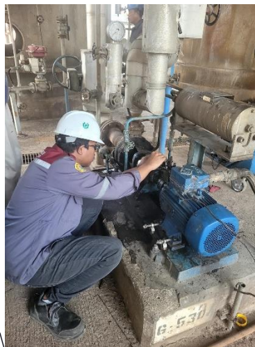
Gambar 5.6 Proses Alignment dengan Metode Rim and Face
