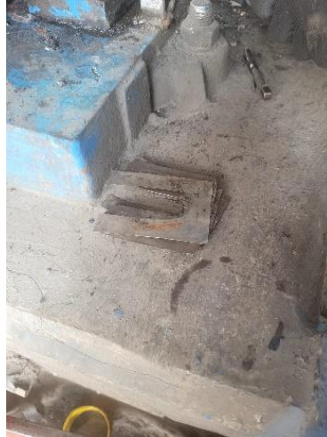
Gambar 5.7 Penambahan Shims Stainless pada Motor Listrik
