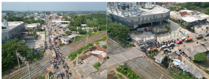
Gambar 1.2 Kondisi Jl. Raya Serpong – Cisauk Sebelum Proyek Flyover Cisauk
