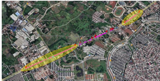
Gambar 5.6 Lokasi Proyek Rehabilitasi dan Peningkatan Jl. Karawaci – Legok (Segmen 2)
