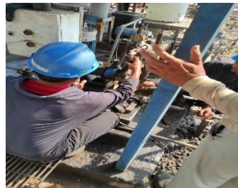
Gambar 4.4 Melepaskan baut penghubung pipa
