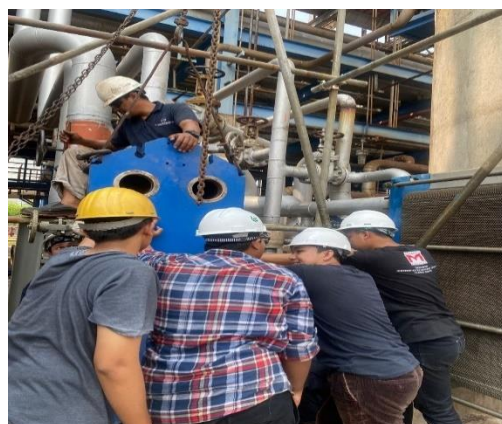
L.5 Proses pemasangan frame PHE
