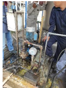
Gambar 4.16 Menyalakan mesin Injection Pump
