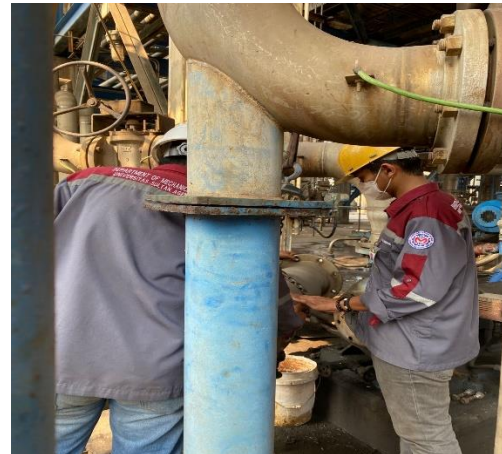
L.2 Proses pemasangan Strainer
