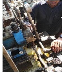
Gambar 4.11 Memasang Head Pump dan pengencangan baut
