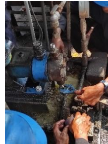
Gambar 4.12 Mengencangkan baut penghubung pipa
