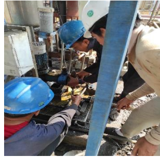
Gambar 4.5 Melepaskan baut Head Pump
