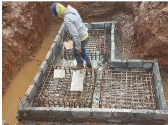
Gambar 4.44 Proses Pemasangan Bekisting Pile Cap
