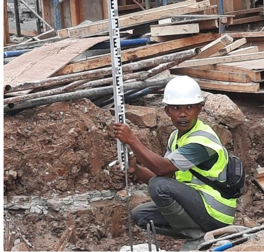
Gambar 4.43 Marking Untuk Posisi Bekisting Pile Cap
