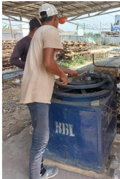
Gambar 4.46 Proses Pembengkokan Menggunakan Bar Bending
