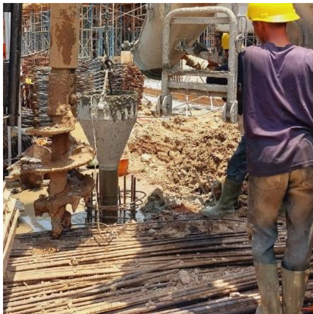
Gambar 4.39 Proses Memasukan Pipa Tremi Kedalam Lubang Bore Pile (Sumber: Dokumen Pribadi, 2023)
