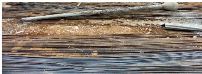
Gambar 4.24 Baja Tulangan (Sumber: Dokumen Pribadi, 2023)
