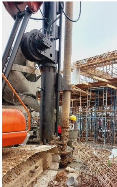
Gambar 4.38 Proses Memasukan Besi Kedasar Lubang Bore Pile
