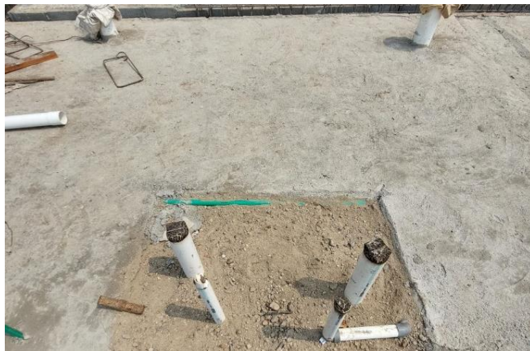
Gambar 4.45 Pembuatan Lantai Kerja
