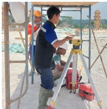
Gambar 4.35 Pengukuran Lokasi Bore Pile
