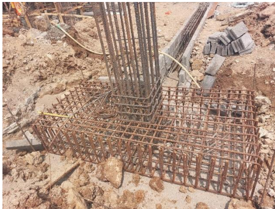
Gambar 3.2 Pile Cap Pada Proyek (Sumber: Dokumen Pribadi, 2023)
