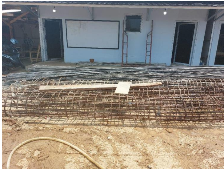
Gambar 3.1 Bore Pile Pada Proyek (Sumber: Dokumen Pribadi, 2023)
