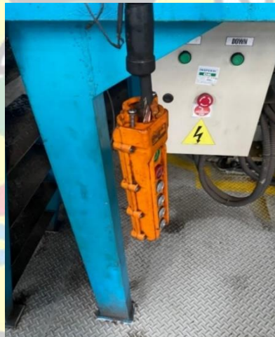
Gambar 6. Penggunaan Remote Control Crane Alat Pengangkat Drum
