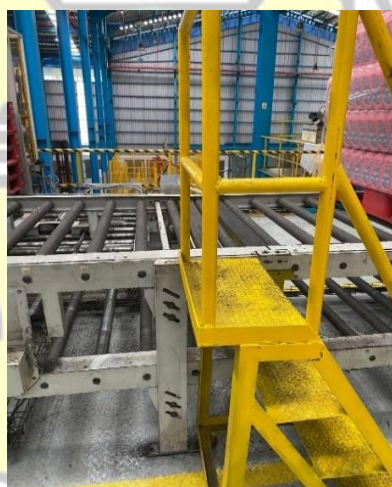
Gambar 10. Akses Jalan pada Lantai 2 Unscramble
