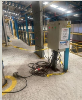
Gambar 8. Kabel Melintang dan Berserakan di Area Blending
