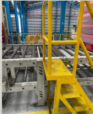
Gambar 10. Akses Jalan pada Lantai 2 Unscramble
