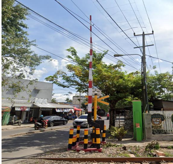
Gambar 5.2 Pintu Perlindungan di Perlindungan Sebidang Jl. Sama'un Bakri (Sumber : Dokumentasi Penulis, 2023)
