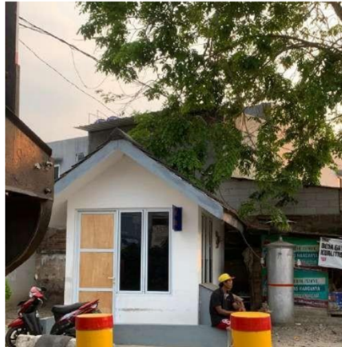
Gambar 5.3 Gardu Jaga di Perlintasan Sebidang Jl. Sama'un Bakri (Sumber : Dokumentasi Penulis, 2023)
