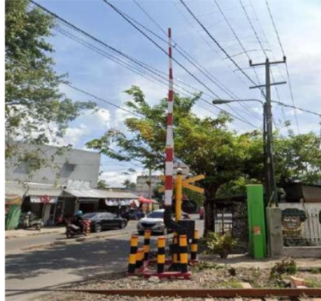
Gambar 5.2 Pintu Perlintasan di Perlintasan Sebidang Jl. Sama'un Bakri (Sumber : Dokumentasi Penulis, 2023)
