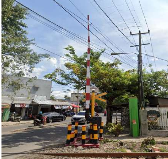
Gambar 5.2 Pintu Perlintasan di Perlintasan Sebidang Jl. Sama'un Bakri
