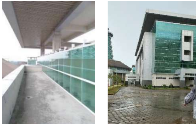
Gambar 4.6 Sisi Belakang Atap dan Sisi Samping Bangunan Gedung Fakultas Hukum Universitas Sultan Ageng Tirtayasa, Sindang Sari
