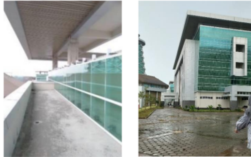
Gambar 4.3 Sisi Belakang Atap dan Sisi Samping Bangunan Gedung Fakultas Hukum Universitas Sultan Ageng Tirtayasa, Sindangsari
