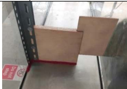
Gambar L-4.4. 2 Pemasangan Pintu Air (Tampak Belakang) Kondisi Pintu terbuka
