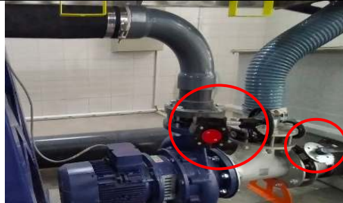
Gambar L-4.1. 2 Pengaturan Katup Pompa Air Dalam Keadaan Open
