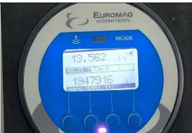
Gambar L-4.2. 7 Pembacaan Q_a = 13,56 l/s Putaran Pompa 4,45 –Kalibrasi Pipa Pitot
