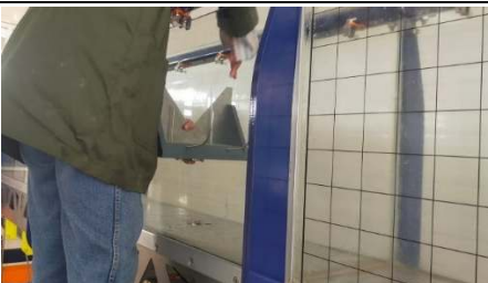
Gambar L-4.1. 7 Pemasangan Peluap Thompson di Saluran
