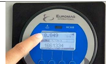
Gambar L-4.3. 3 Pembacaan Q_a = 8,849 l/s Putaran Pompa 4,0 –Kondisi Pintu Tertutup
