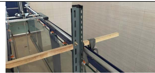
Gambar L-4.4. 18 Perkuatan Samping Model Dengan Besi Siku –Kondisi Pintu Terbuka
