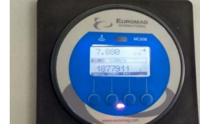
Gambar L-4.2. 3 Pembacaan Q_a = 7,88 l/s Putaran Pompa 3,45 –Kalibrasi Pipa Pitot
