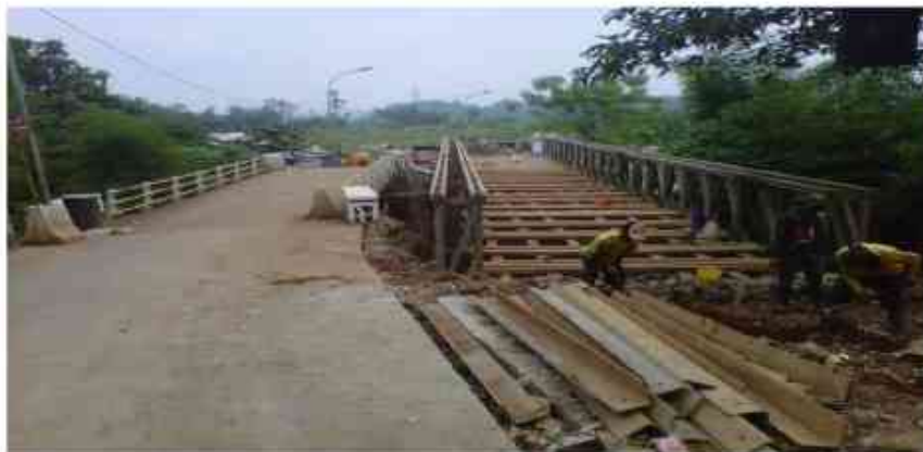
Gambar 4.5 Kondisi Akses Jalan Menuju TPA
