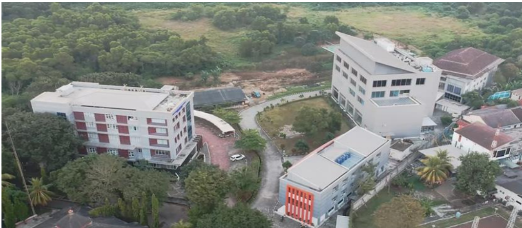
Gambar 5.1. Gedung Dekanat, Gedung Kuliah BR, dan Gedung COE
