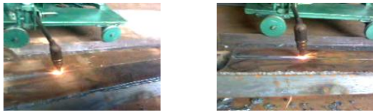
Gambar 3.5 Nyala api yang baik pada waktu proses pemotongan plat
