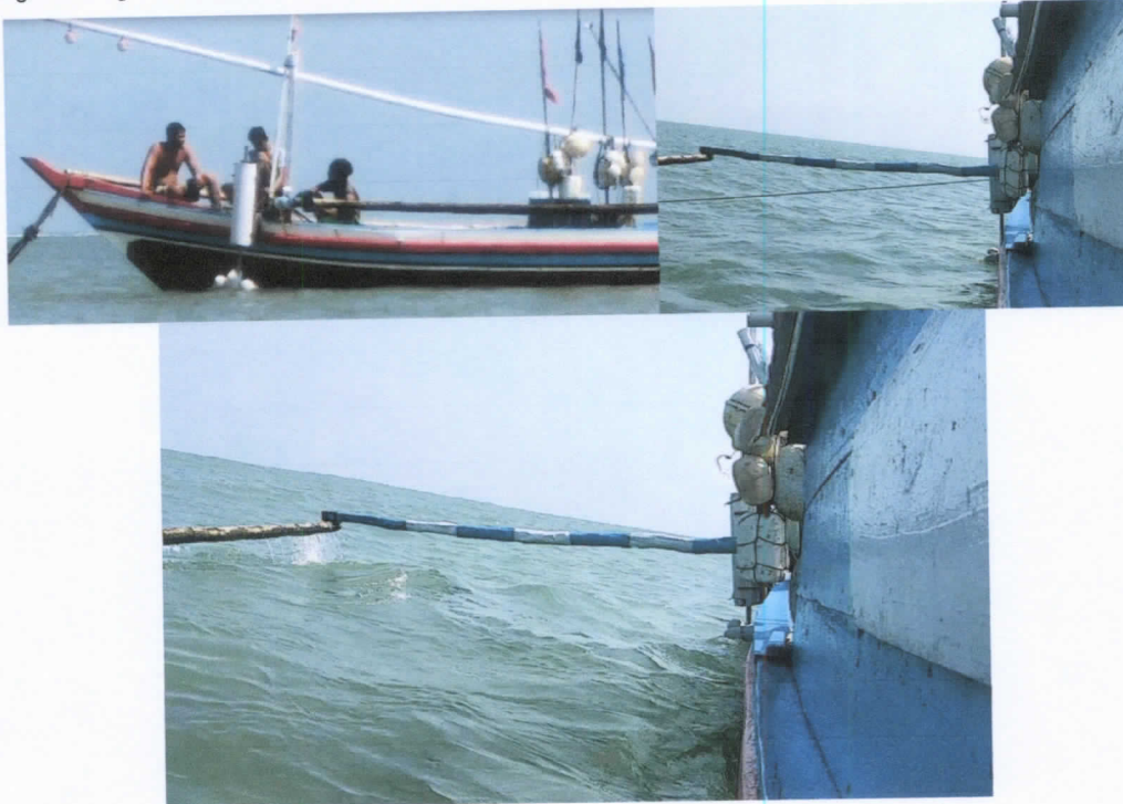
Gambar 9 Kapal dan mitra nelayan pada saat pemasangan generator PLTGL
