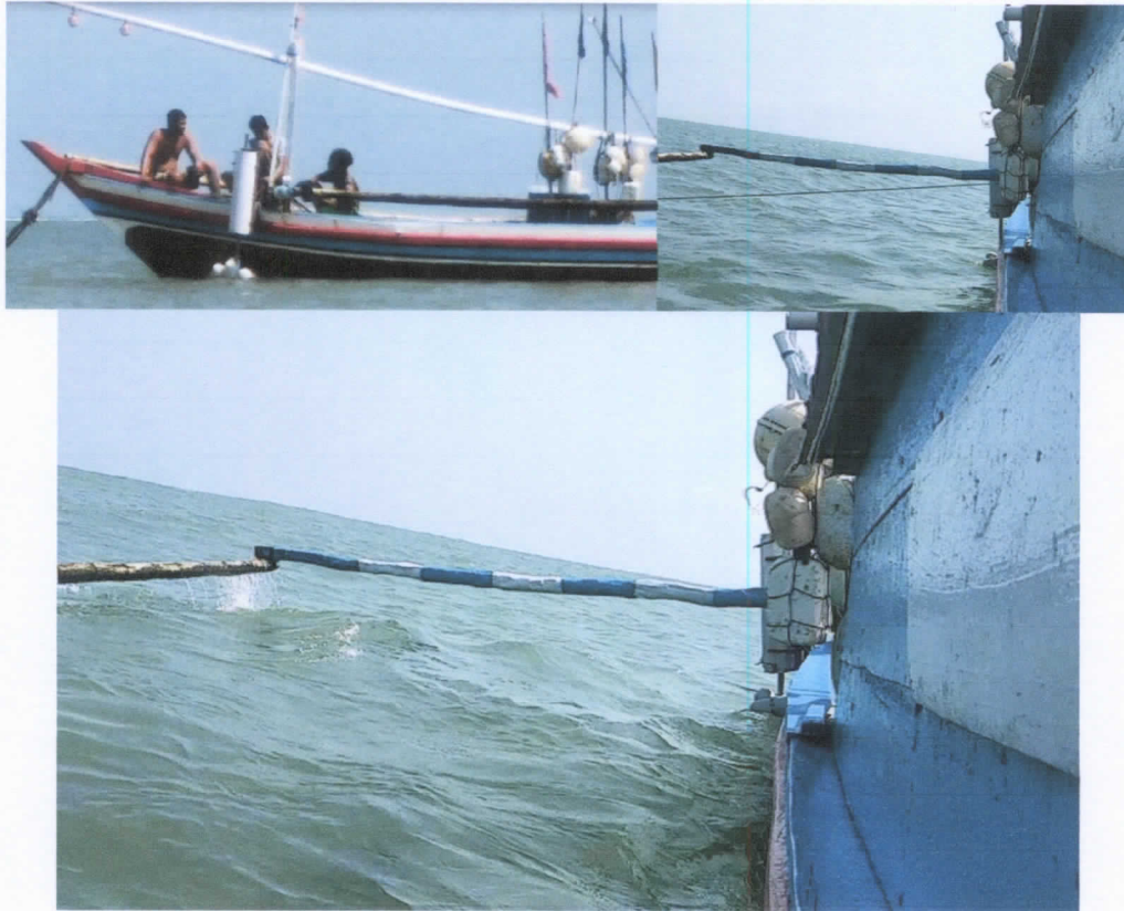
Gambar 7. Kapal dan mitra nelayan pada saat pemasangan generator PLTGL
