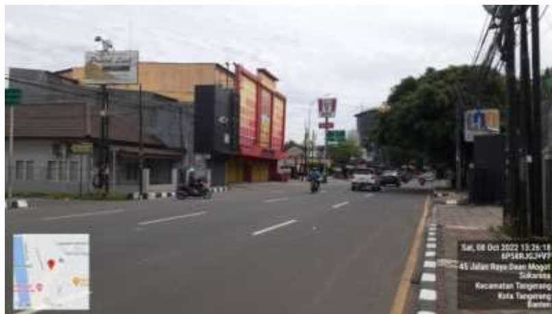
Gambar 5.3 Keadaan Jalan Segmen 1 Sukarasa, Tangerang
