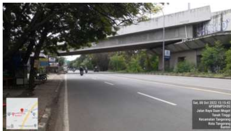
Gambar 5.7 Keadaan Jalan Segmen 3 Tanah Tinggi, Tangerang
