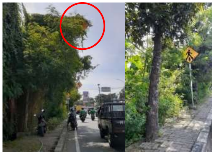
Gambar 5.46 Kondisi Rambu yang Tertutup Ranting Pohon
