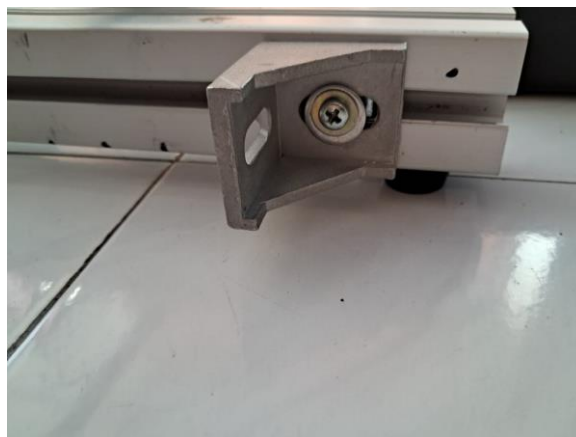
Tahap 3 Pemasangan siku pada batang
