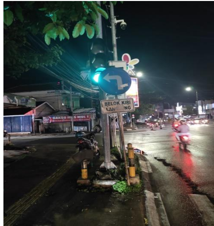
Rambu Perintah (Warna Rambu Memudar) Tidak Sesuai dengan PERMENHUB No.13 Tahun 2014
