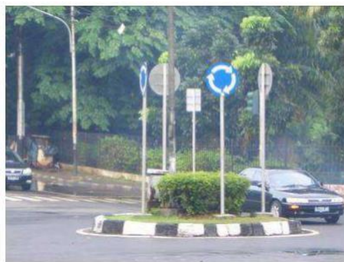
Gambar 3.20 Penempatan rambu perintah pada sisi jalan sesuai dengan perintah Sumber : Paduan Penempatan Fasilitas Jalan
