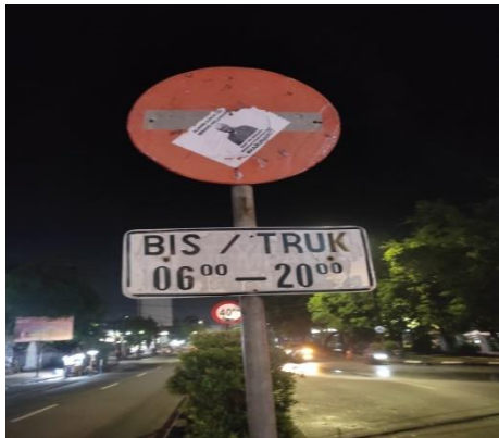
Rambu Larangan (Rambu Memudar) Tidak Sesuai dengan PERMENHUB No.13 Tahun 2014
