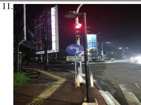
Rambu Perintah (Warna Rambu Memudar) Tidak Sesuai dengan PERMENHUB No.13 Tahun 2014
