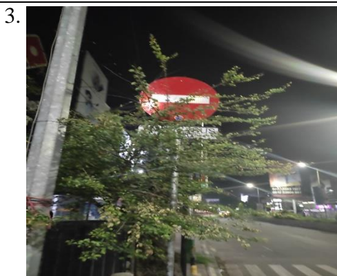
Rambu Larangan (Rambu Terhalang Pohon) Tidak Sesuai dengan PERMENHUB No.13 Tahun 2014
