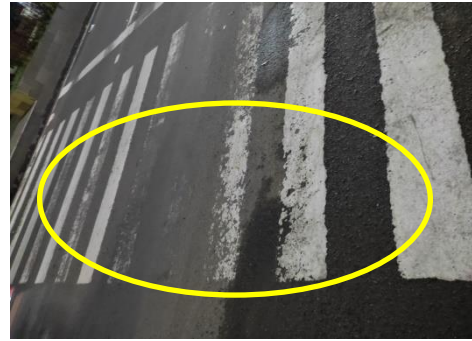
Marka Penyembrangan Pudar (Jl. Jendral Ahmad Yani)
