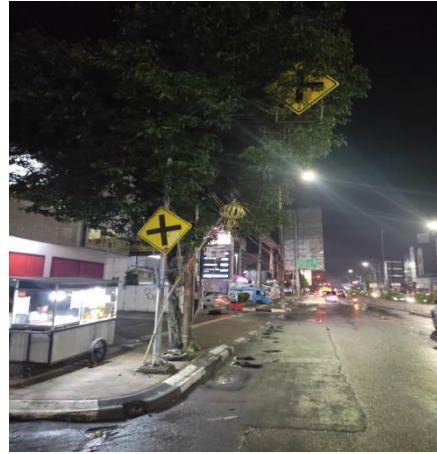
Rambu Peringatan (Rambu Terhalang Pohon dan Daun Rambu Miring) Tidak Sesuai dengan PERMENHUB No.13 Tahun 2014
