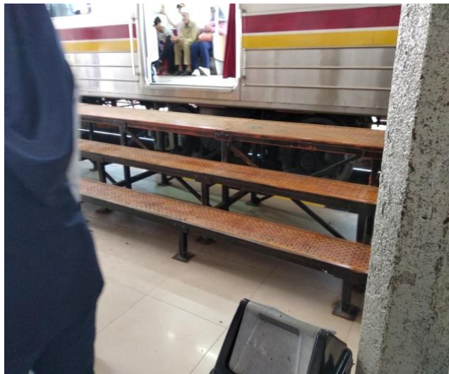
Gambar 1.4 Tidak Adanya Jalur Untuk Penyandang Disabilitas di Tangga Peron
