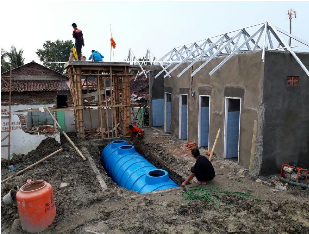
Proses pembangunan MCK di Kelurahan Margaluyu
