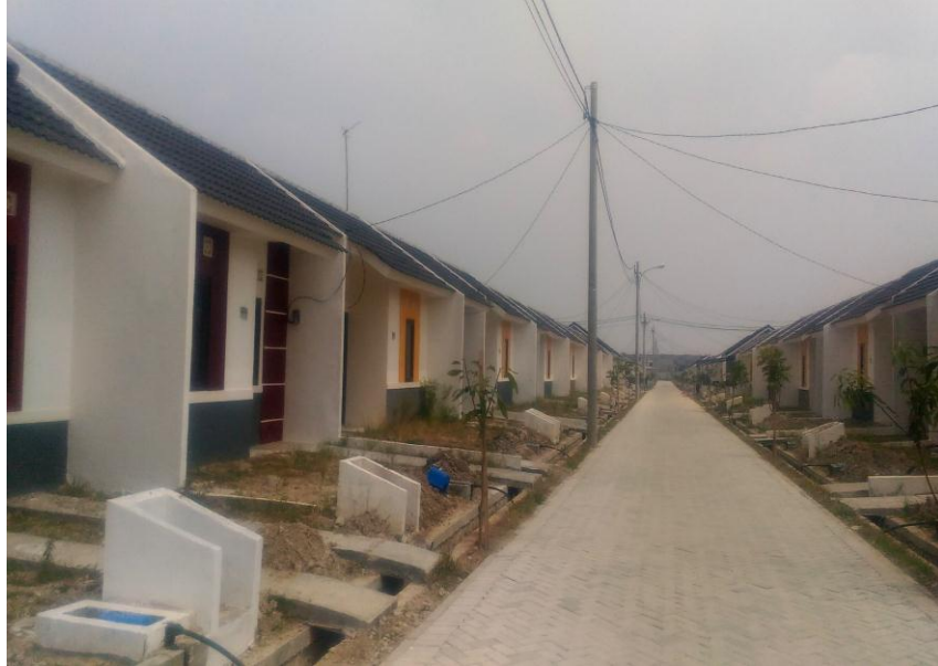
Area Perumahan Permata Mutiara Maja di Desa Curug Badak
