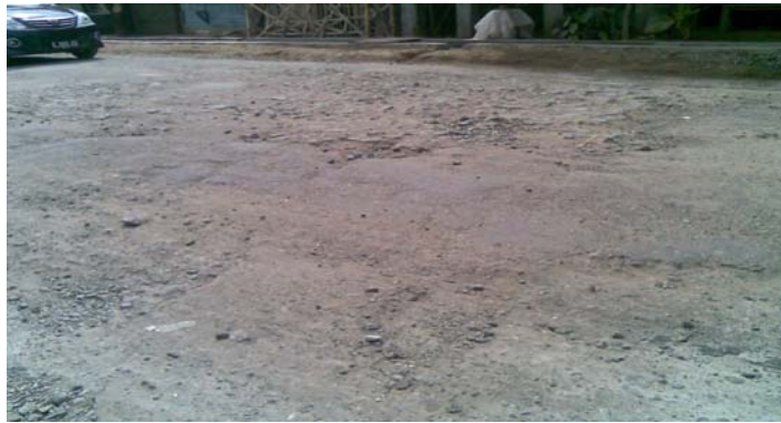
Gambar 4.1 Jalan rusak di daerah Caringin – Carita Kabupaten Pandeglang
