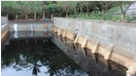
Gambar 2. Penampungan air lindi di TPSA Bagendung
