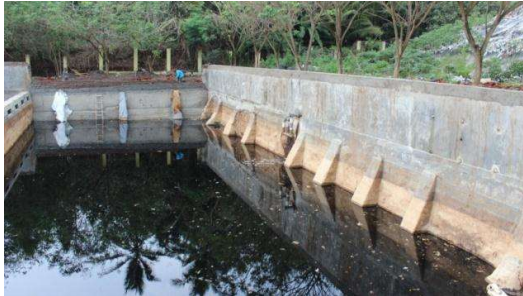
Gambar 2. Penampungan air lindi di TPSA Bagendung
